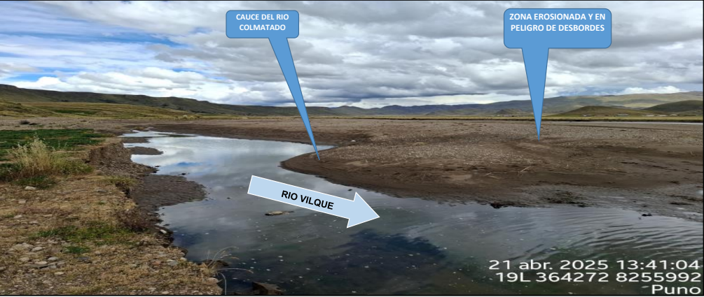
FIGURA 01 : TRAMO CRÍTICO EN EL RÍO VILQUE, SE APRECIA LA ACUMULACION DE MATERIAL SEDIMENTADO EN EL CAUCE, QUE REQUIERE SER ELIMINADO PARA REESTABLECER LA SECCION HIDRAULICA DE LA CAJA DEL CAUCE EN ESTE SECTOR.
